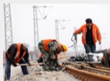
黄韩侯铁路西段电气化复线施工进展顺利
