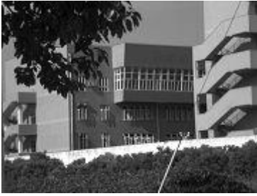
图 4. 57. 为劳教所新盖大楼
